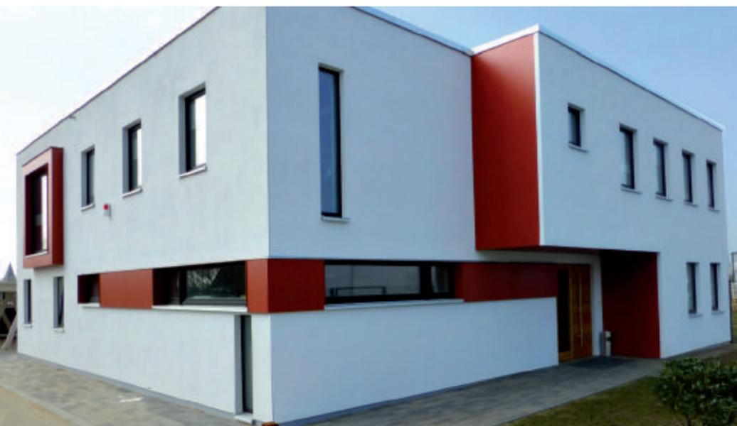
Das Bürogebäude ist der Sitz der Zimmermeister Karsten Jantzen GmbH und wurde als Holzrahmenbau realisiert mit einem um ein Atrium organisierten 1. Obergeschoss. Die Fassaden sind vorwiegend verputzt und mit Applikationen aus HPL-Fassadenplatten versehen. Die Beheizung erfolgt über eine Kombination aus Erdwärme und Holzvergaserheizung.
