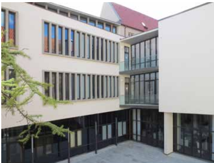
Sanierung Rathauskomplex der Hansestadt Rostock, Zwischenbau Große Wasserstraße, Innenhof Schustergarten
