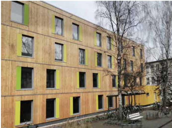
Südseite nach dem Abrüsten, Dezember 2020
