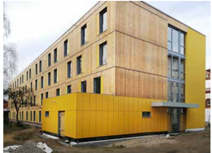
Südseite nach dem Abrüsten, Dezember 2020 (Hausanschlussraum)
