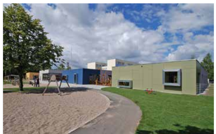
Schwerin, Eulerstraße/ Neubau Kita, 2011
