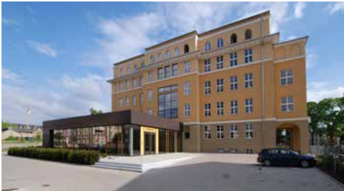
Schwerin, Robert-Koch-Straße 42/ Umbau Krankenhaus zum VR-Bank-Haus, 2015
