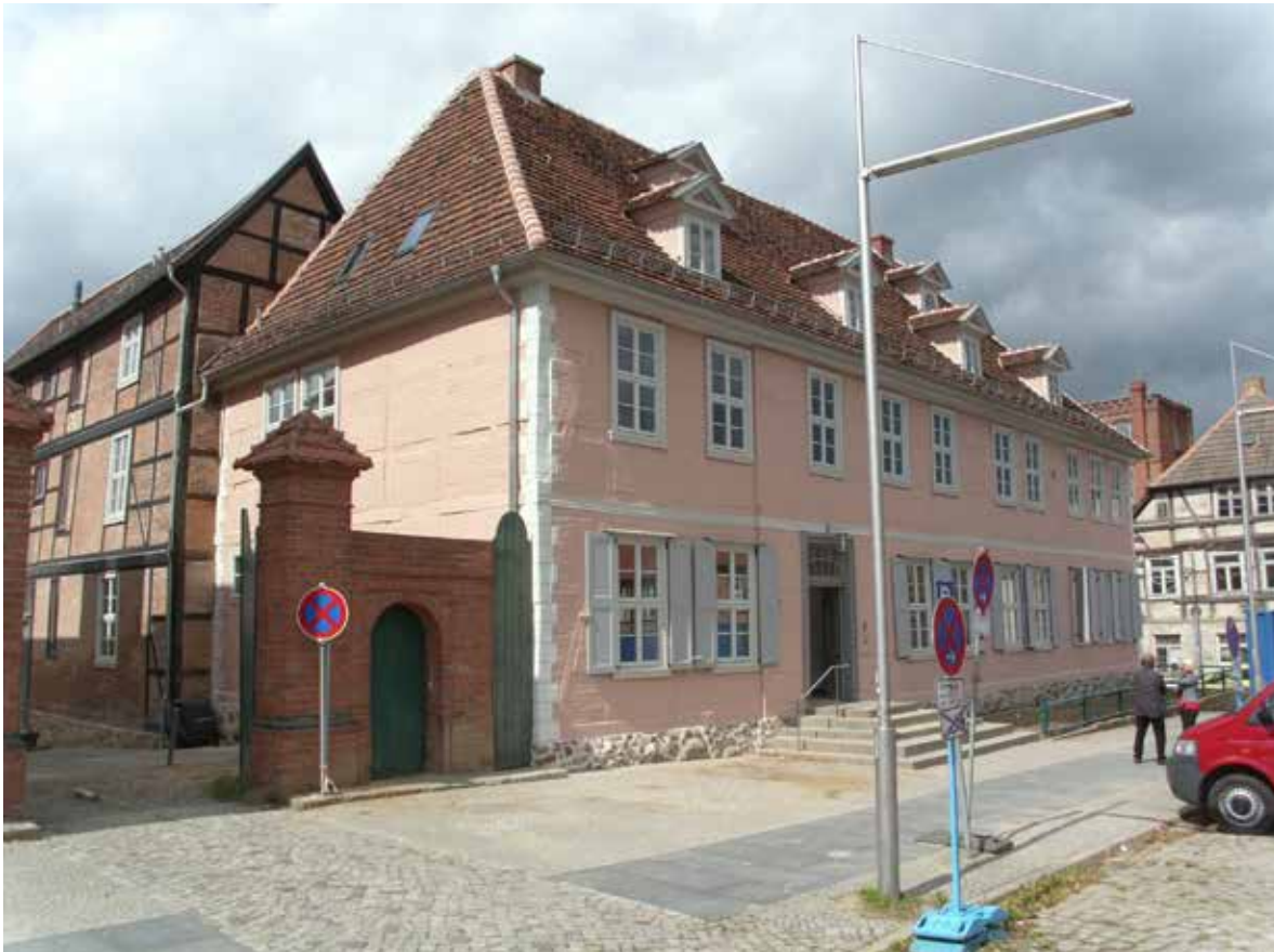
Denkmalgeschütztes Fachwerkpalais, Schelfmarkt 1 in Schwerin, Sanierung 06-2010 bis 08-2011
