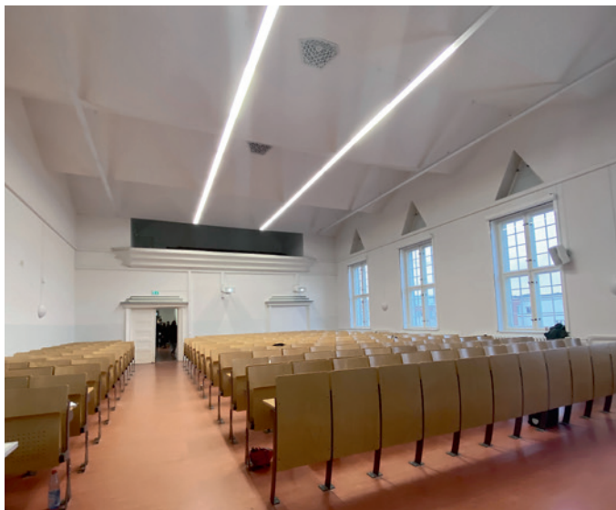
Das Sanierungskonzept sieht für den Hörsaal mit originaler Rabitz-Decke sensible Maßnahmen u. a. der Akustik und Beleuchtung vor
